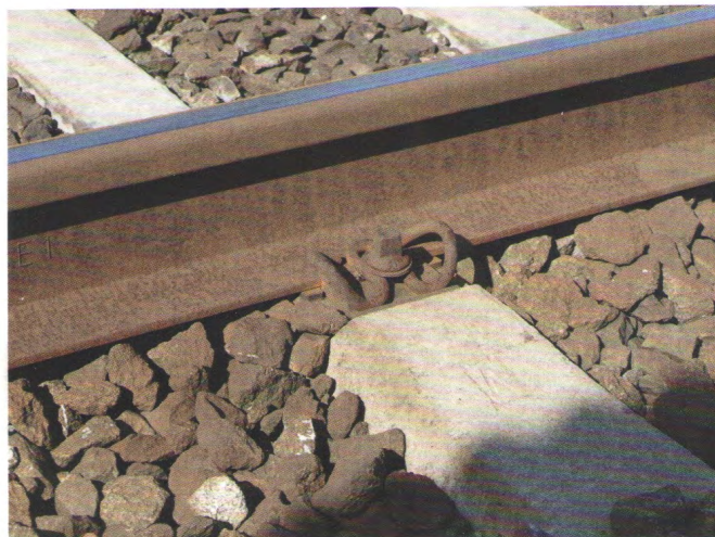
Obr. 2 – Upevnění kolejnic v lokalitě Svojšovice [autoři]
