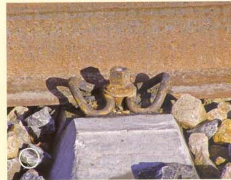
Obr. 2 Měřené konstrukční typy upevnění kolejníc, a) pružné podkladnicové typu KS, b) tuhé podkladnicové typu K, c) pružné přímé typu W14
