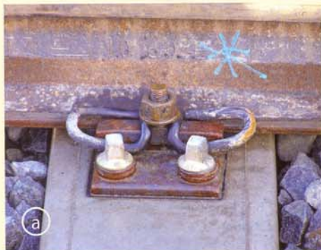
Obr. 2 Měřené konstrukční typy upevnění kolejníc, a) pružné podkladnicové typu KS, b) tuhé podkladnicové typu K, c) pružné přímé typu W14
