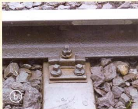
Obr. 2 Měřené konstrukční typy upevnění kolejníc, a) pružné podkladnicové typu KS, b) tuhé podkladnicové typu K, c) pružné přímé typu W14
