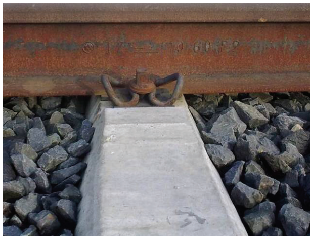
Obr. 6 Přímé pružné upevnění bezpodkladnicové – W 14 (zdroj: autoři)
