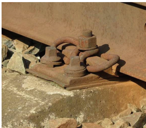
Obr. 5 Nepřímé pružné upevnění s žebrovými podkladnicemi – typ KS (zdroj: autoři)
