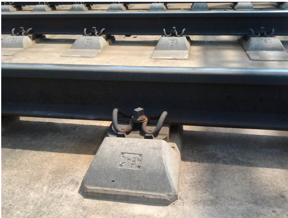
Obr. 7 Pevná jízdní dráha typu RHEDA 2000 s detailem přímého pružného bezpodkladnicového upevnění typu Vossloh 300 (zdroj: autoři)
