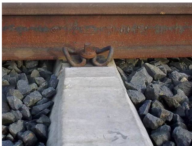
Obr. 6 Přímé pružné upevnění bezpodkladnicové – W 14 (zdroj: autoři)
