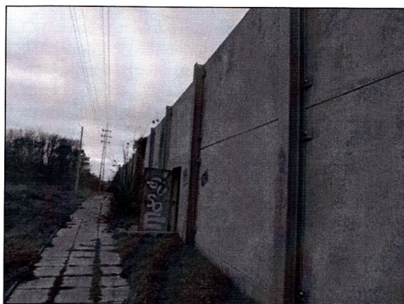
Obr. 3: Protihluková stěna v Praze Průhonicích.
